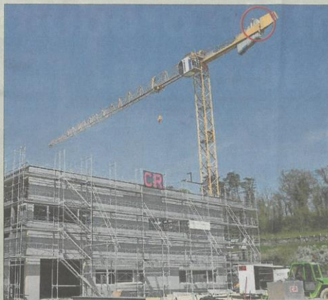
Un couple de cigognes s'est établi au sommet de la grue du chantier de l'usine relais et son propriétaire ne peut ainsi pas démonter son engin comme prévu. PHOTOS MN
