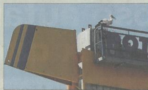
Aux premières loges du chantier de construction.
